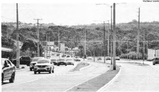
Estrada do Araçagi tem sido chamada de Estrada da Morte, por causa dos constantes acidentes no trânsito
