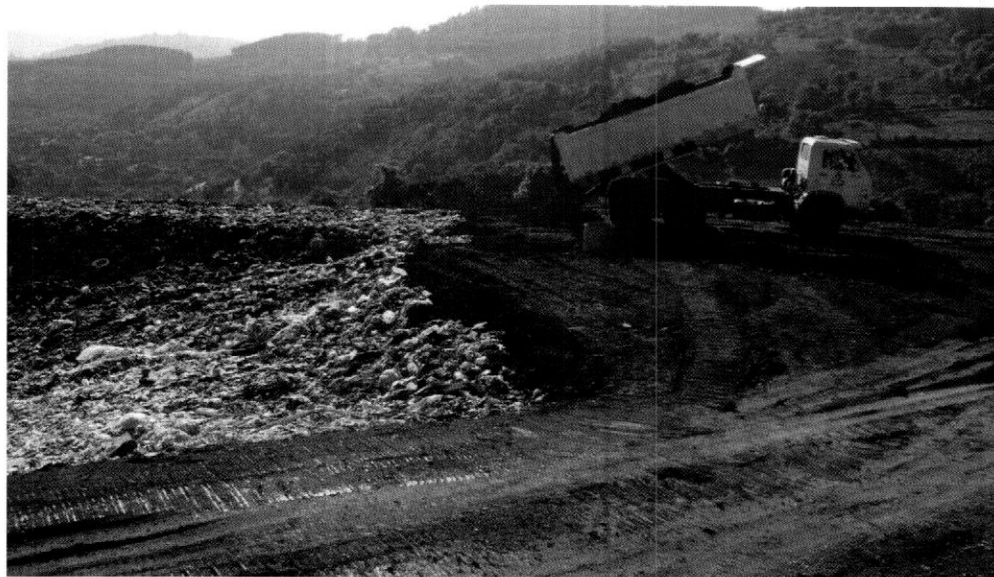
Figura 36 - Cobertura diária dos resíduos
