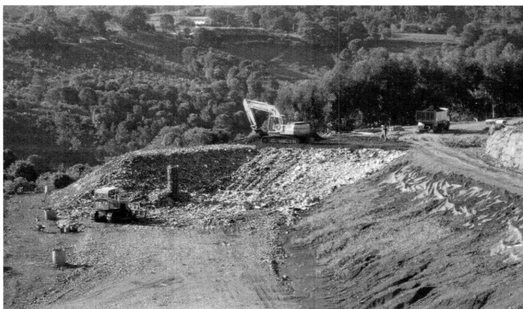
Figura 34 - Frente de serviço em aterro sanitário CRI
