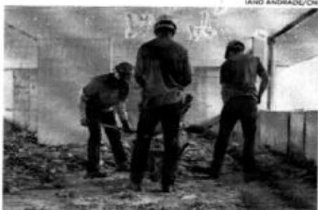
A construção civil teve um saldo de 227, uma queda elevada em comparação ao mês anterior
