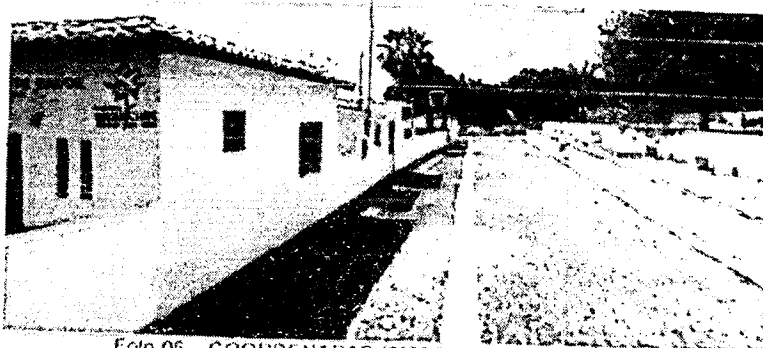
Foto 06 - COORDENADAS (3°32'39.84"S, 43°55'6.63"W)
