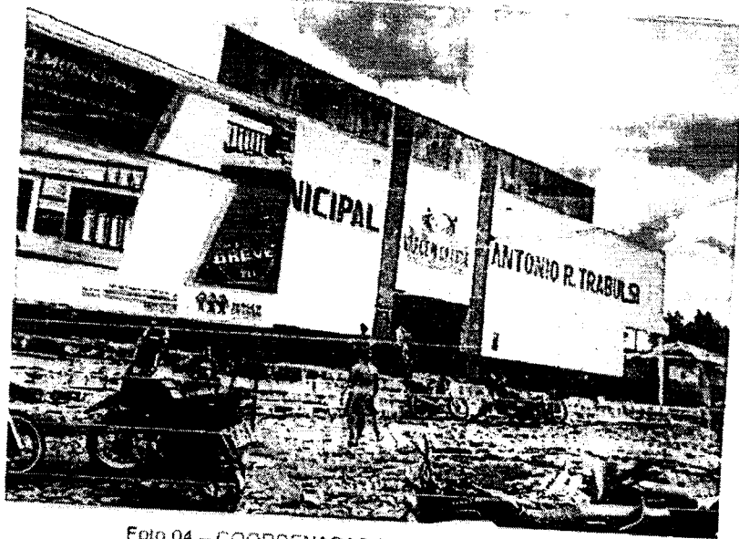
Foto 04 - COORDENADAS (3°32'29.42"S, 43°55'4 09"W)
