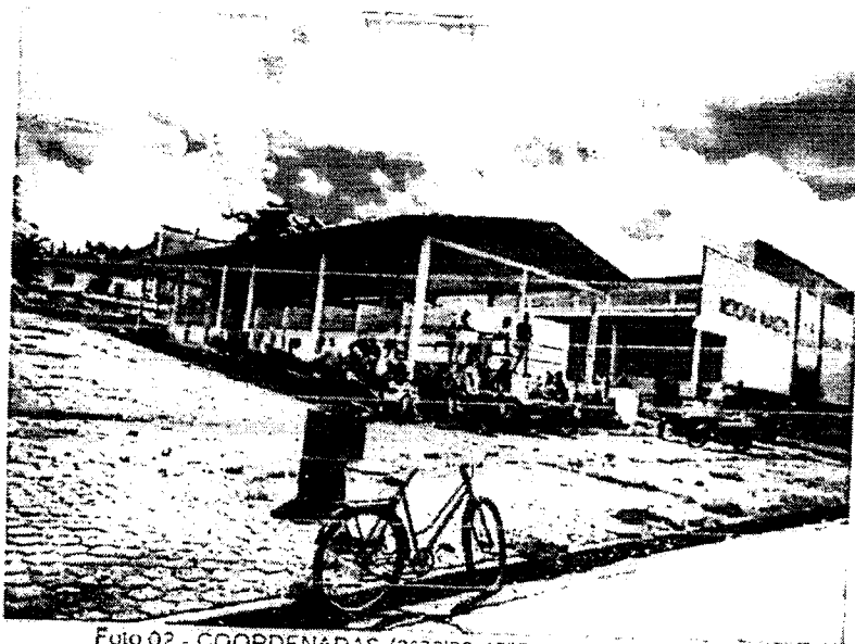
Foto 02 - COORDENADAS (3°32'29.45"S, 43°55'5.21"W)
