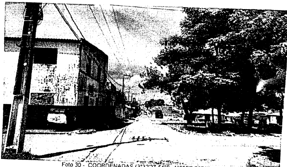
Foto 30 - COORDENADAS (3°32'27.54"S, 43°55'2.28"W)
