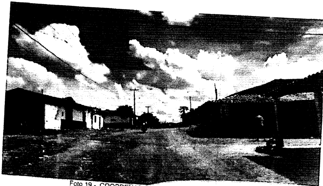
Foto 19 - COORDENADAS (3°32'17.75"S, 43°55'34.40"W)
