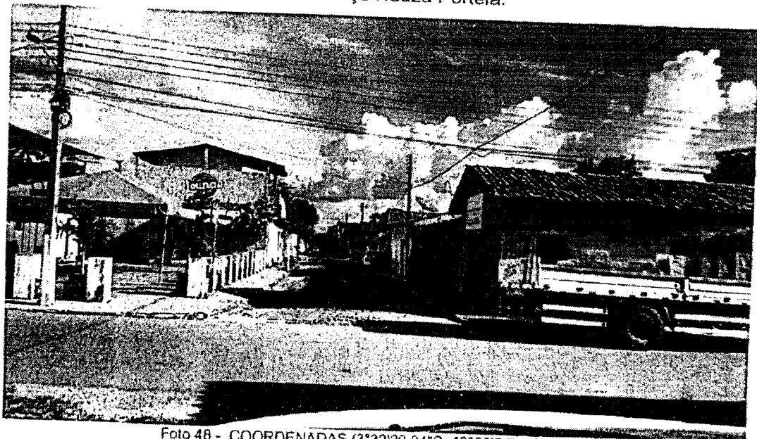
Foto 48 - COORDENADAS (3°32'29.34"S, 43°55'5.51"W)
